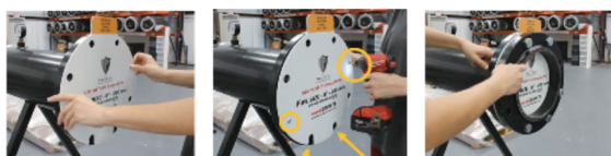
写真20 モックガスケットの仮合わせ
